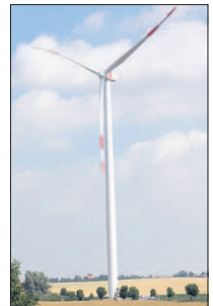
Dieser insgesamt rund 150 Meter hohe Prototyp vor Kirch Mulchow soll am 6. August offiziell eingeweiht werden.
