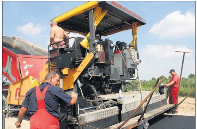
Hanko Matzke, 37000 Penzin und Nils Klein (v.l.) von der Satower Firma Rask Mecklenburg brachten gestern mit ihrem „Fertiger“ rund 3500 Quadratmeter Tragschicht für eine neue Asphaltstraße zwischen Kirch Mulchow und Garvensdorf auf.
